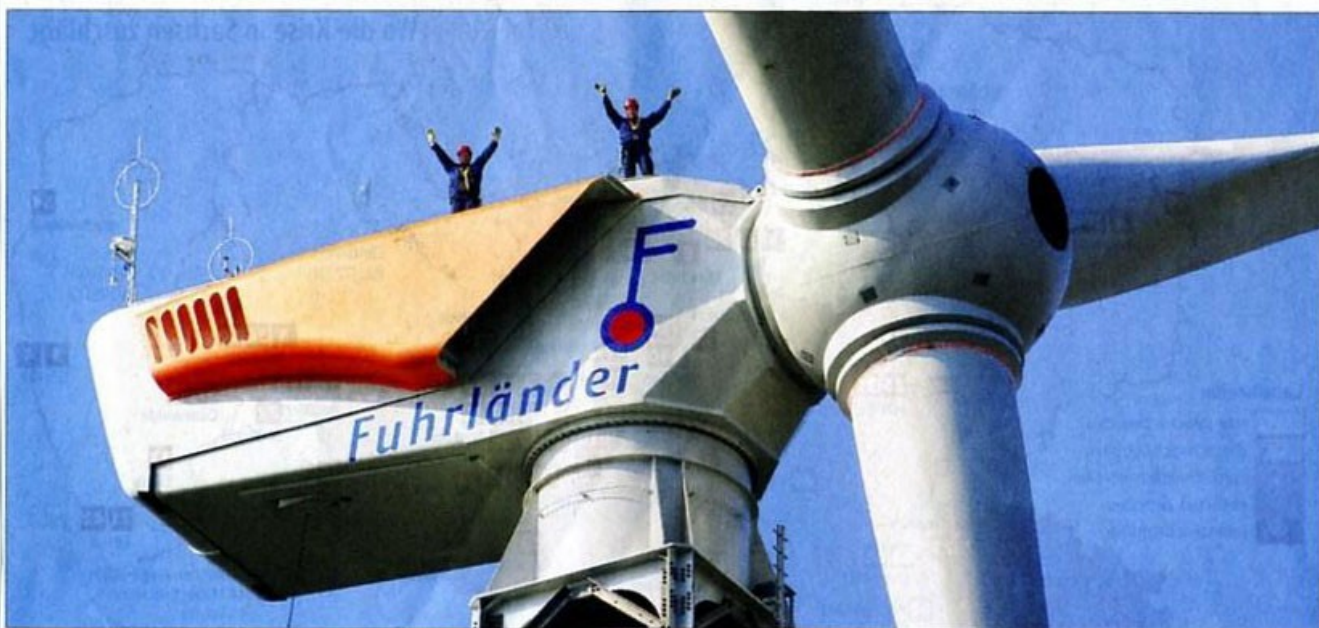
Winken in 141 Meter Höhe: Im südbrandenburgischen Spremberg steht diese Windkraftanlage, die von der Dresdner WSB betrieben wird. In Sachsen findet der Landesverband Windenergie kaum Regionen, in denen solche Energieriesen mit 2,5 Millionen Watt Leistung erlaubt werden. Foto: dpa/Patrick Pleul
